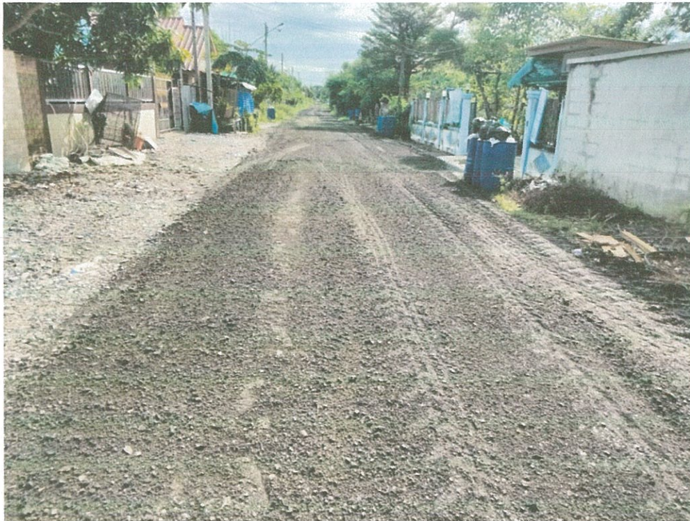
ภาพ ที่นำกากยางไปปรับปรุงซ่อมแซมถนนสาธารณะ
