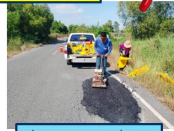
ซ่อมแซมกลบหลุมบ่อถนน ในพื้นที่ตำบลบางสมบูรณ์
